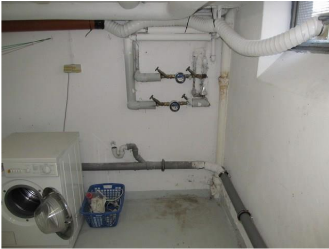
Der Waschraum mit eigenem Anschluss,...
