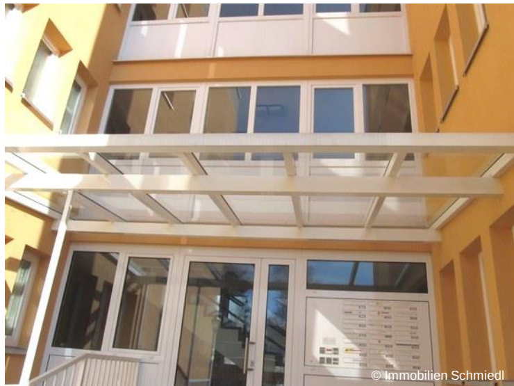
Freundlicher sanierter Eingangsbereich....
